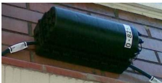
Figura 1: Caja terminal óptica (CTO) de exterior
