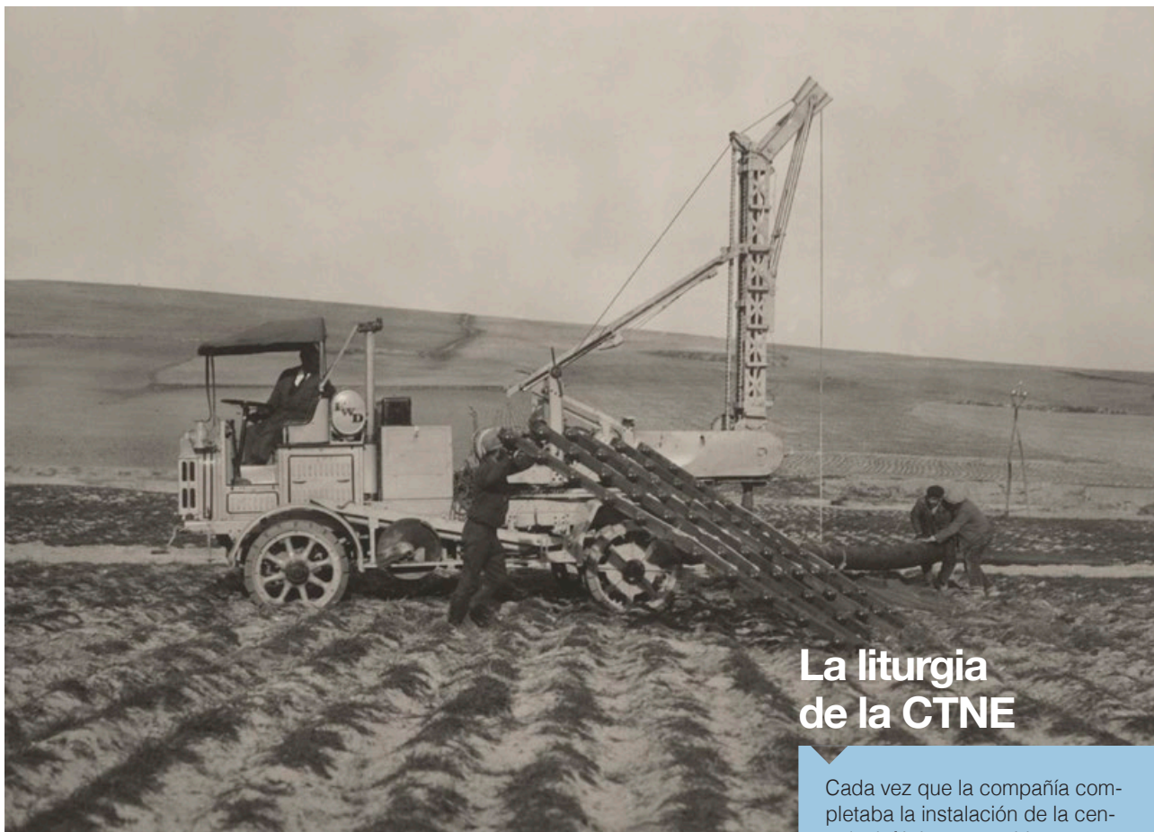
Camión grúa-perforadora usada por la CTNE para plantar los postes de las redes telefónicas interurbanas. (Fuente: Telefónica, 1926).
