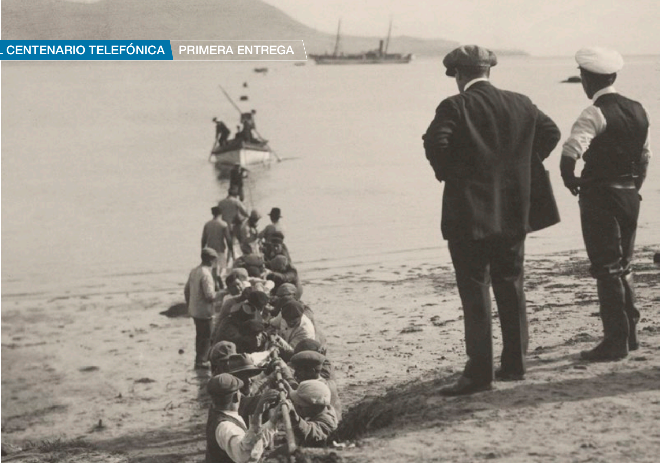
Tendido del cable telefónico submarino entre Algeciras y Ceuta. Al fondo puede verse el barco cablero "Amber" fletado para esta tarea. Fuente: Telefónica (1924). Autor: © "Alfonso", VEGAP, Madrid, 2024.
