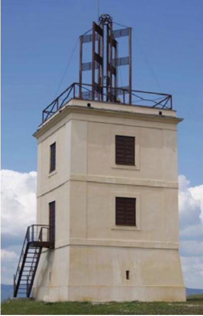
Torre reconstruida de doble bastidor de Monterredondo (Madrid).
