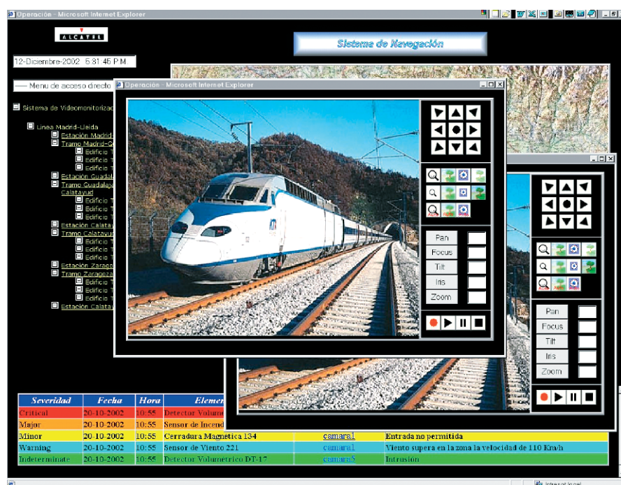
Sistema de control de cámara.
