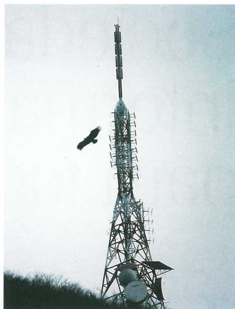
Torre de Monreal
