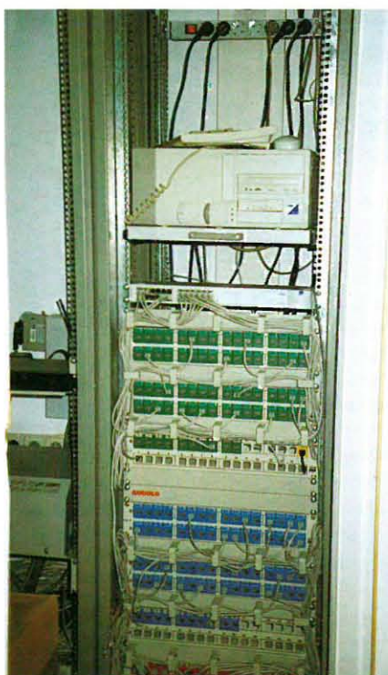
Fotografía del Sistema de Cableado Estructurado y Red de Área Local instalado en el Colegio Oficial de Ingenieros de Telecomunicación
