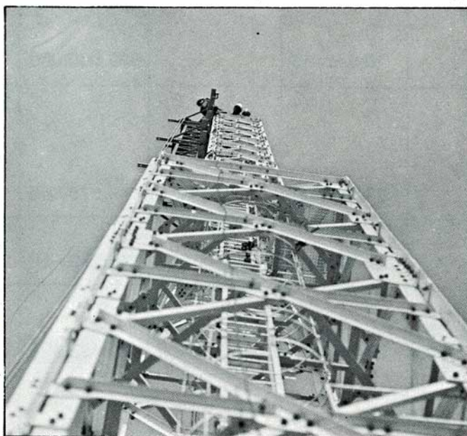
Instalación del mástil de antena sobre la torre de la M-30.
