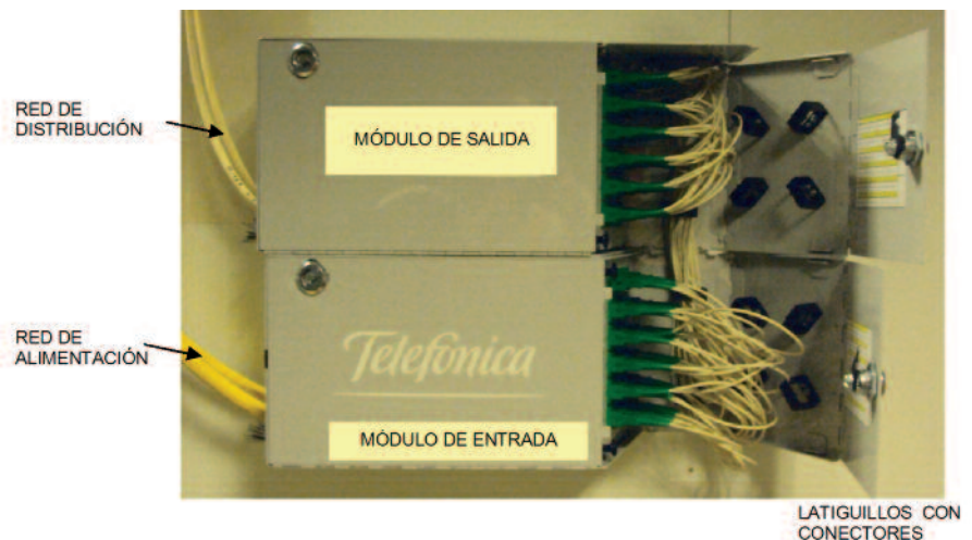
Figura 2. Punto de interconexión de F.O. en RITI
